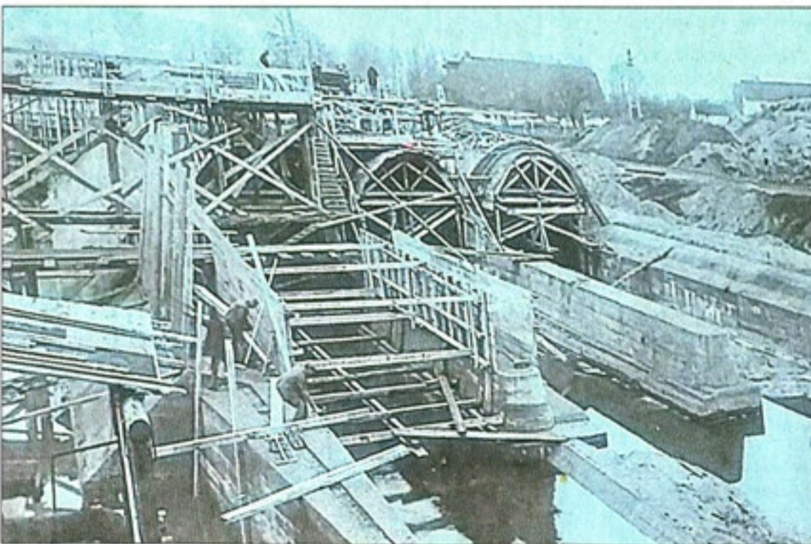
Dieses Bild zeigt die einstige Baustelle, die überschwemmt worden war.
